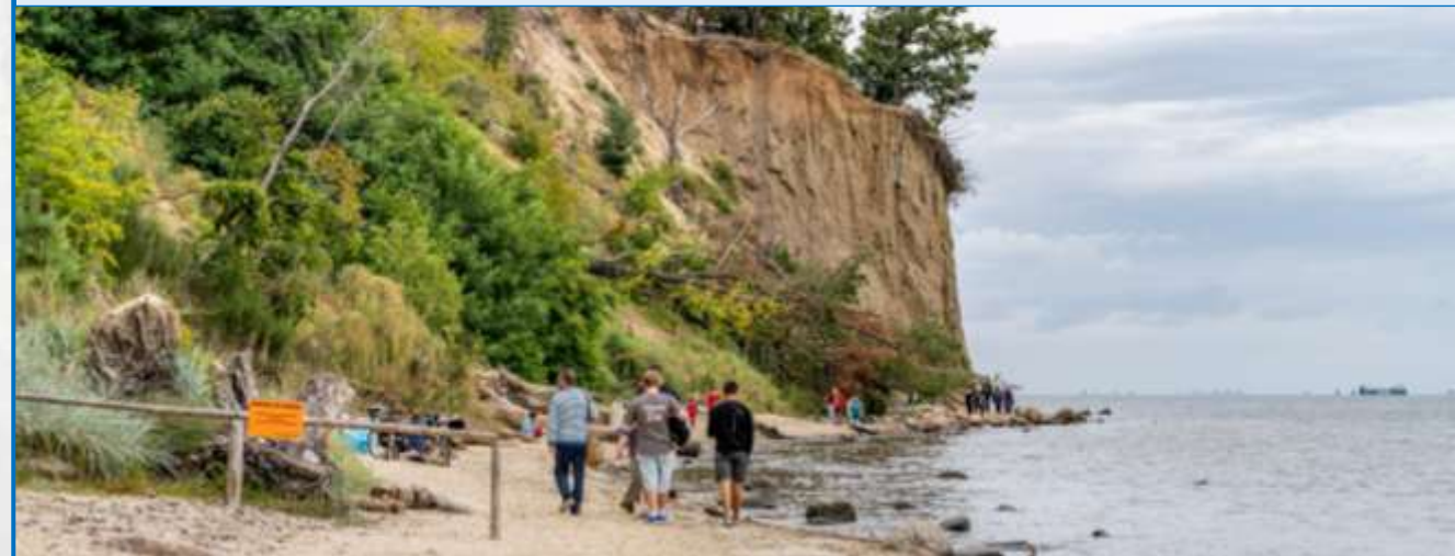
Klif Orłowski w Gdyni zbudowany z gliny morenowej i osadów wodnolodowcowych, które są stosunkowo słabo skonsolidowane (obrywy zachodzą zwykle często obejmując jednorazowo małe skały)
