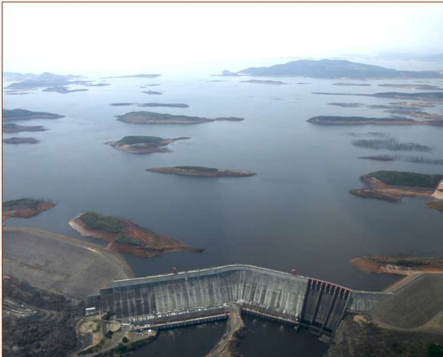
Guri – hydroelektrownia w Wenezueli na rzece Caroni Zapora o wysokości 162 m i zbiornik retencyjny o powierzchni 4,2 tys. km 2 .
